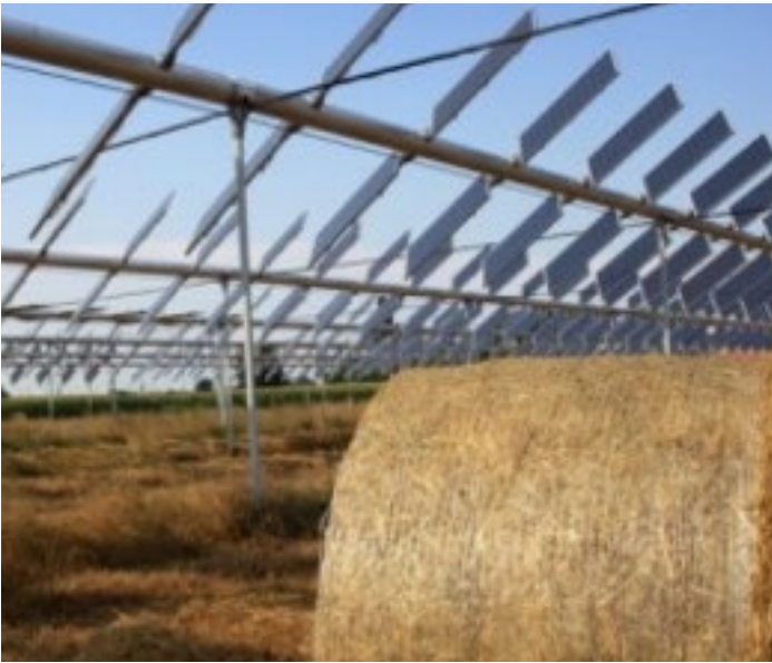
Installazione agrovoltica per ottenere energia verde a chilometro 0
