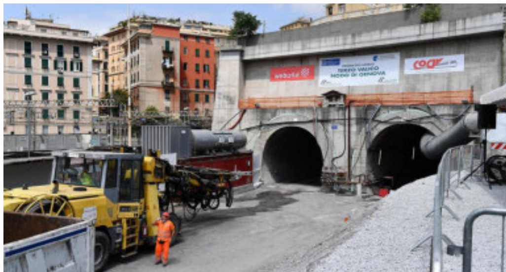
LAVORI IN CORSO per il Terzo Valico dei Giovi
