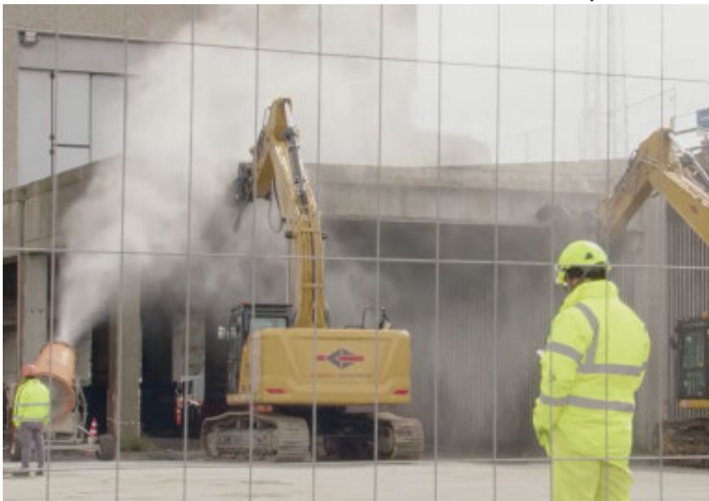
CANTIERE AL VIA Ieri mattina a pochi passi dalla Lanterna, è iniziata la realizzazione del tunnel
