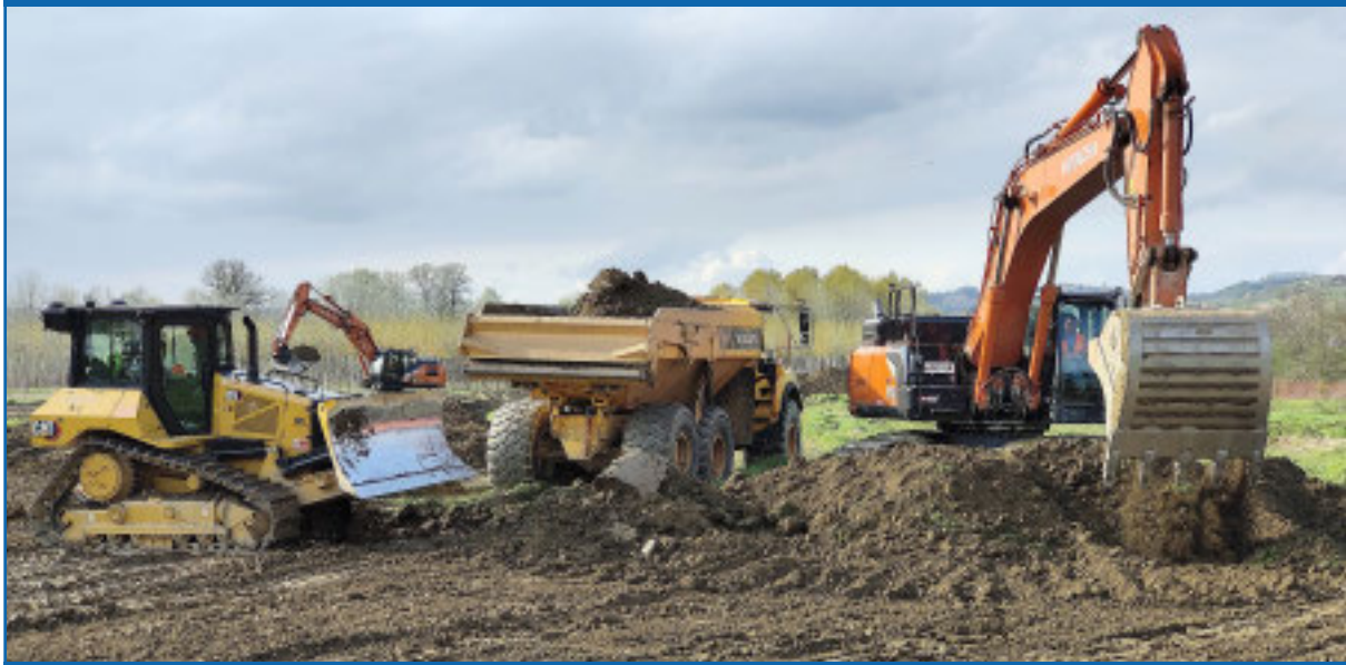
Lavori al viadotto di Verduno - A PAGINA 5
