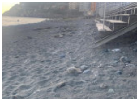
Gradini pericolosi dalla passeggiata
