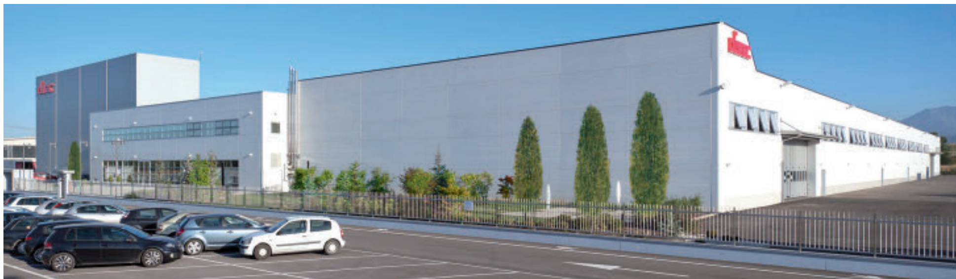
Stabilimento Olimac di Margarita (CN) totalmente robotizzato (superficie di proprietà di 90.000 mq)
