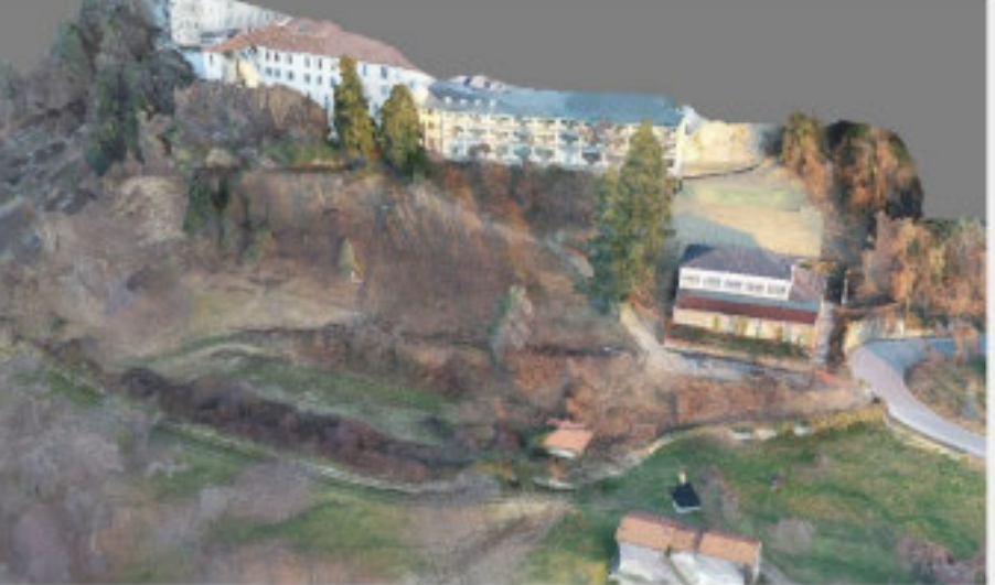
Re.n.Di.S. - Messa in sicurezza della collina di Piazza
