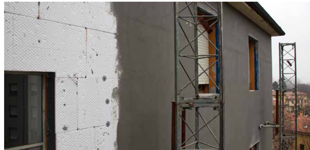
Cantieri infiniti. Lavori in corso in tutta la penisola
