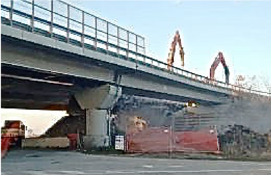
I lavori di abbattimento
