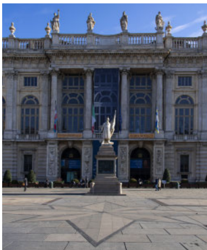
La facciata dello storico edificio in piazza Castello
