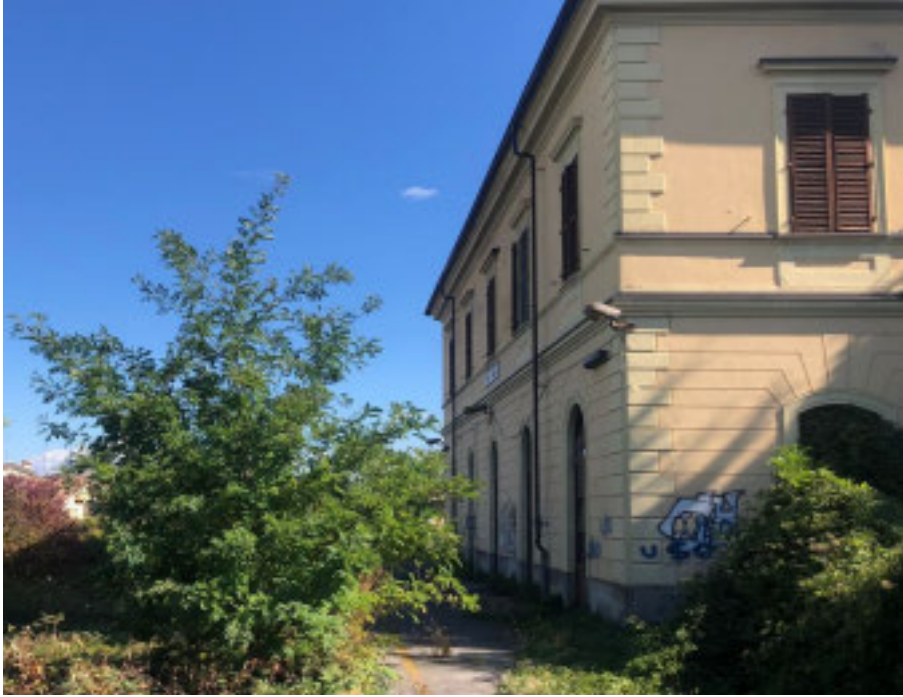
Stazione di Beinette, ormai da anni in abbandono
