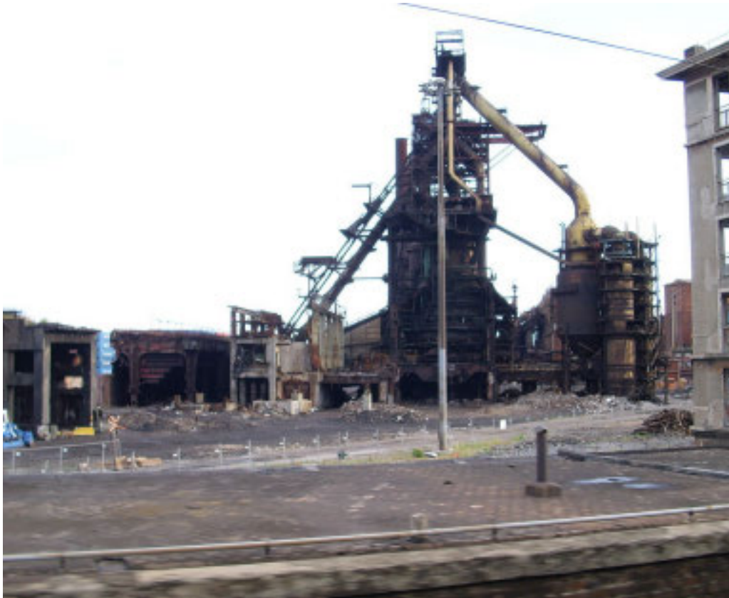
ARCHEOLOGIA INDUSTRIALE L'altoforno dismesso alle Acciaierie di Cornigliano
