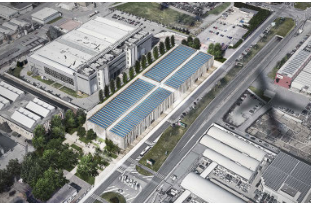
Il cantiere darà lavoro a 14 mila persone, con 1,15 miliardi di investimenti complessivi
