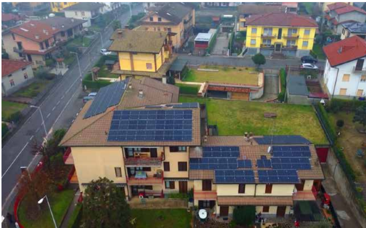
Condominio Dalmine. Realizzato da GabettiLab
