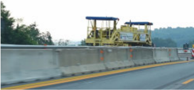
1° CANTIERE, POCO DOPO L'ENTRATA DI MONDOVI' Erano presenti mezzi, ma non operai
