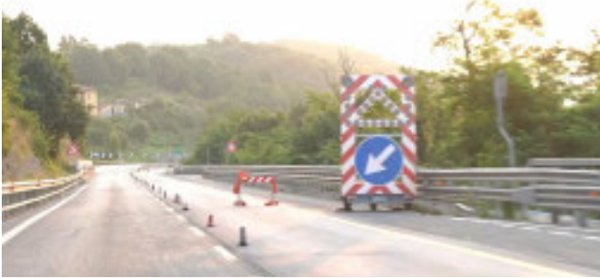
6° CANTIERE, PRIMA DEL VIADOTTO PRIERA in quest'occasione erano presenti operai a lavoro
