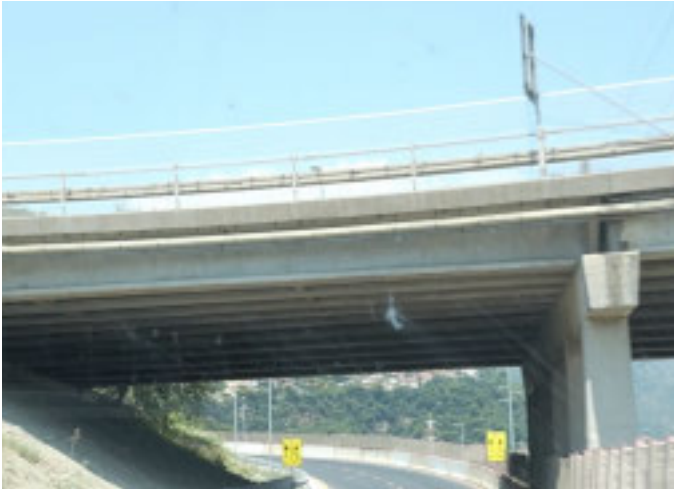
11° CANTIERE, SVINCOLO DI VENTIMIGLIA La situazione dello svincolo può essere definita caotica
