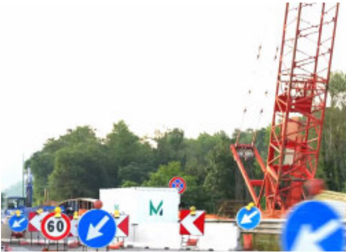
5° CANTIERE, PRIMA DELLA GALLERIA DI MONTECALA Non è segnalabile la presenza di lavoratori, ma di molti mezzi
