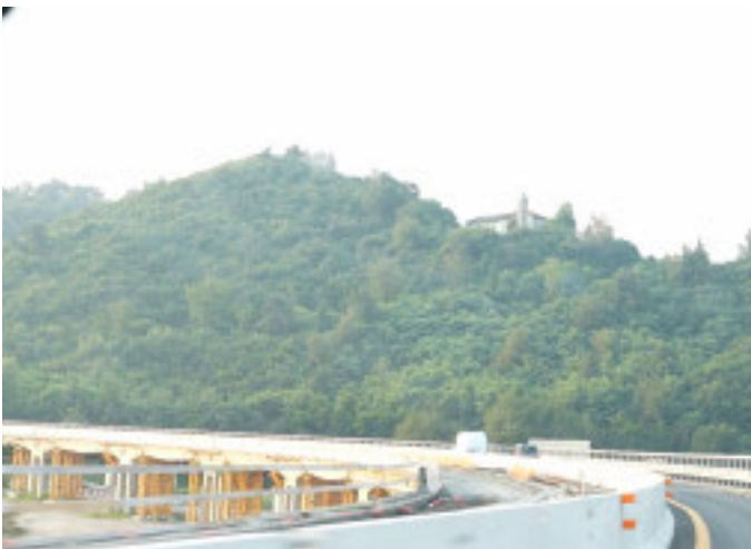
8° CANTIERE, fra Carcare e Altare L'immagine cattura bene la situazione in cui versa il ponte
