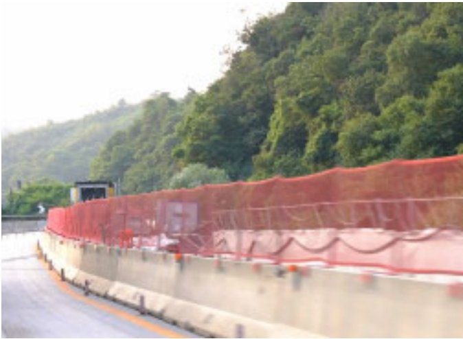
3° CANTIERE, IN CORRISPONDENZA DEL VIADOTTO ZEMOLA si registra la presenza di macchine operatrici e lavoratori
