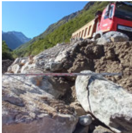
Lavori post alluvionali in valle Gesso
