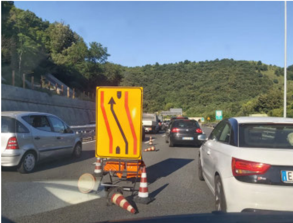
STOP AI LAVORI in vista del «ponte» del 2 giugno
