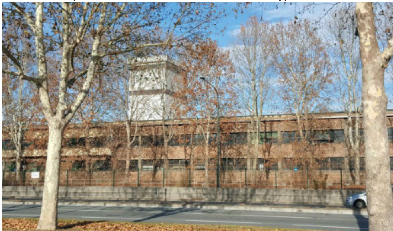
La ex fabbrica della ThyssenKrupp, in corso Regina Margherita 400 a Torino
