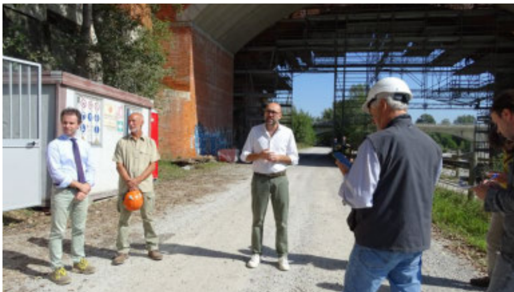
L'intervento di Robaldo al sopralluogo
