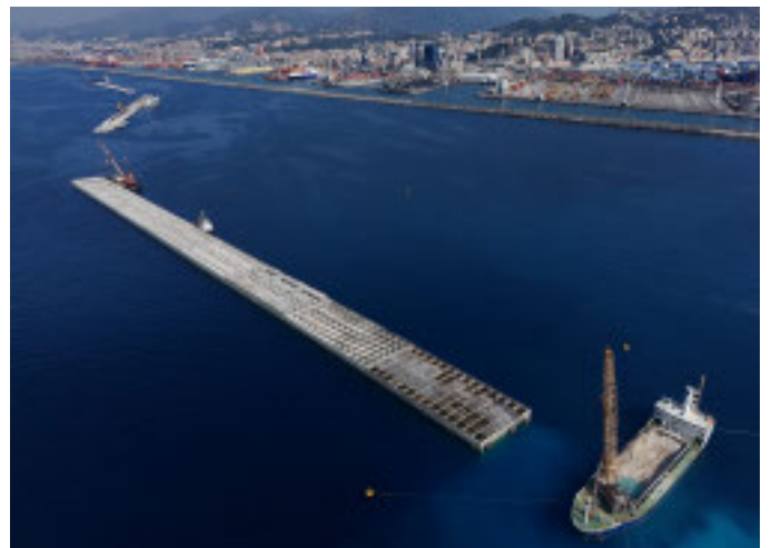
La diga di Genova in costruzione
