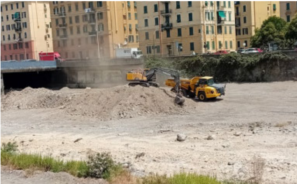
Si lavora nel letto del Bisagno sotto la piastra di copertura di Genova Est
