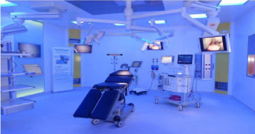
Tra le nuove tecnologie c'è l'installazione del sistema Tegriss
