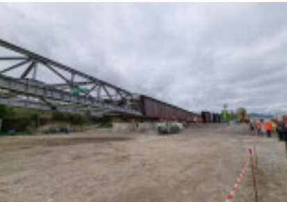
Il momento del varo dell'impalcato
