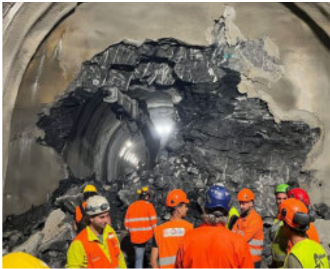
Lavori al tunnel di Tenda
